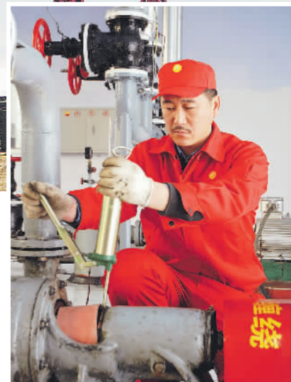
鞠岳军在维修保养集输设备。王洪彪 摄
