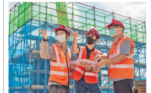
7月25日,西亚赫明(中)在位于马来西亚彭亨州的马东铁项目六分部施工现场工作。新华社记者 朱炜摄
