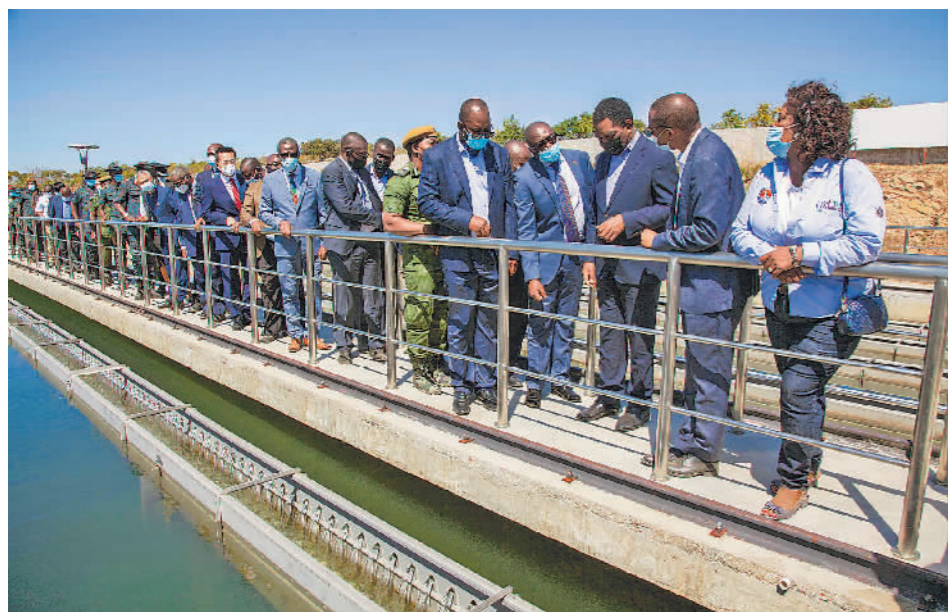
7月29日,赞比亚总统希奇莱马(右三)在卢萨卡卡富埃埃参访卡富埃河供水项目。赞比亚总统希奇莱马29日出席中企承建的卡富埃河供水项目一期工程竣工仪式。该项目是集取水、净水、输水为一体的综合性供水工程,将每天向赞比亚首都卢萨卡供水5万立方米,为当地人民提供充足、清洁、安全的水资源。新华社发(马丁·姆班圭塔摄)
